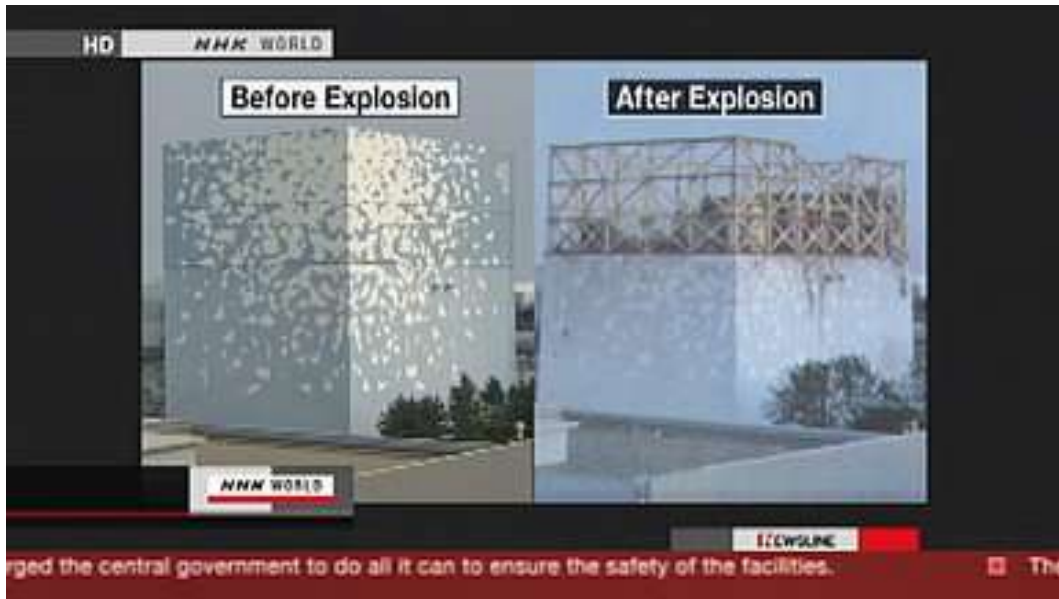
โครงสร้างภายนอกของอาคารเครื่องปฏิกรณ์ฯ ที่ได้รับความเสียหาย (ภาพข่าวจากสถานีโทรทัศน์ NHK)
